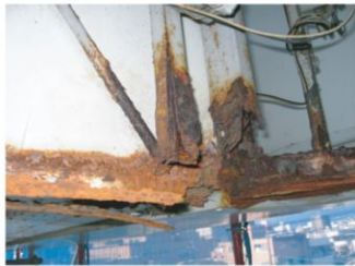
屋外広告塔下端鉄骨
