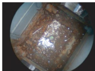
ブラケット内部鉄骨
