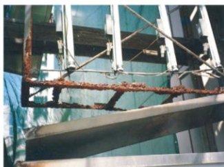
袖看板内部鉄骨
