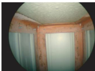
袖看板内部鉄骨
