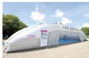
バルーンシェルター 専用の送風機でふくらませるだけで、40分程度で簡単にできあがり、2基1セットで約100人が横になれる収容能力を持っています。
